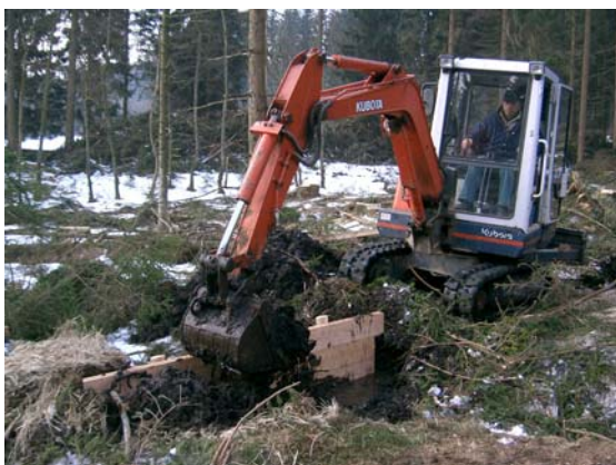
Bau eines Bretterdamms im Holzbach-Demonstrationsgebiet und Ansicht im Frühjahr darauf
